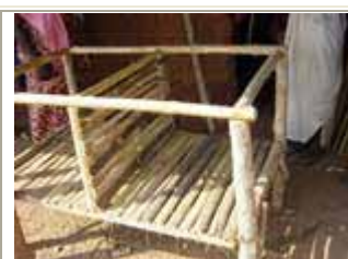
Figure 29b : Exemple d'une cage avec un fond en bambou, en cours de construction
