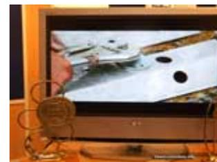
Les plaques d'aluminium se fixent sur les tire-fonds de la toiture
