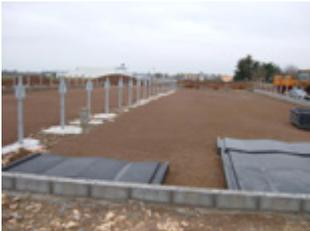
Mise en place des éléments en W simplement sur le sol compacté avant la construction du bâtiment
