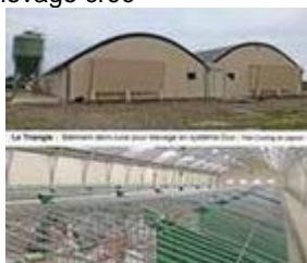
Exemple de bâtiment Duo pour lapins avec couverture en demi-lune, réalisé par les Ets Le Triangle
